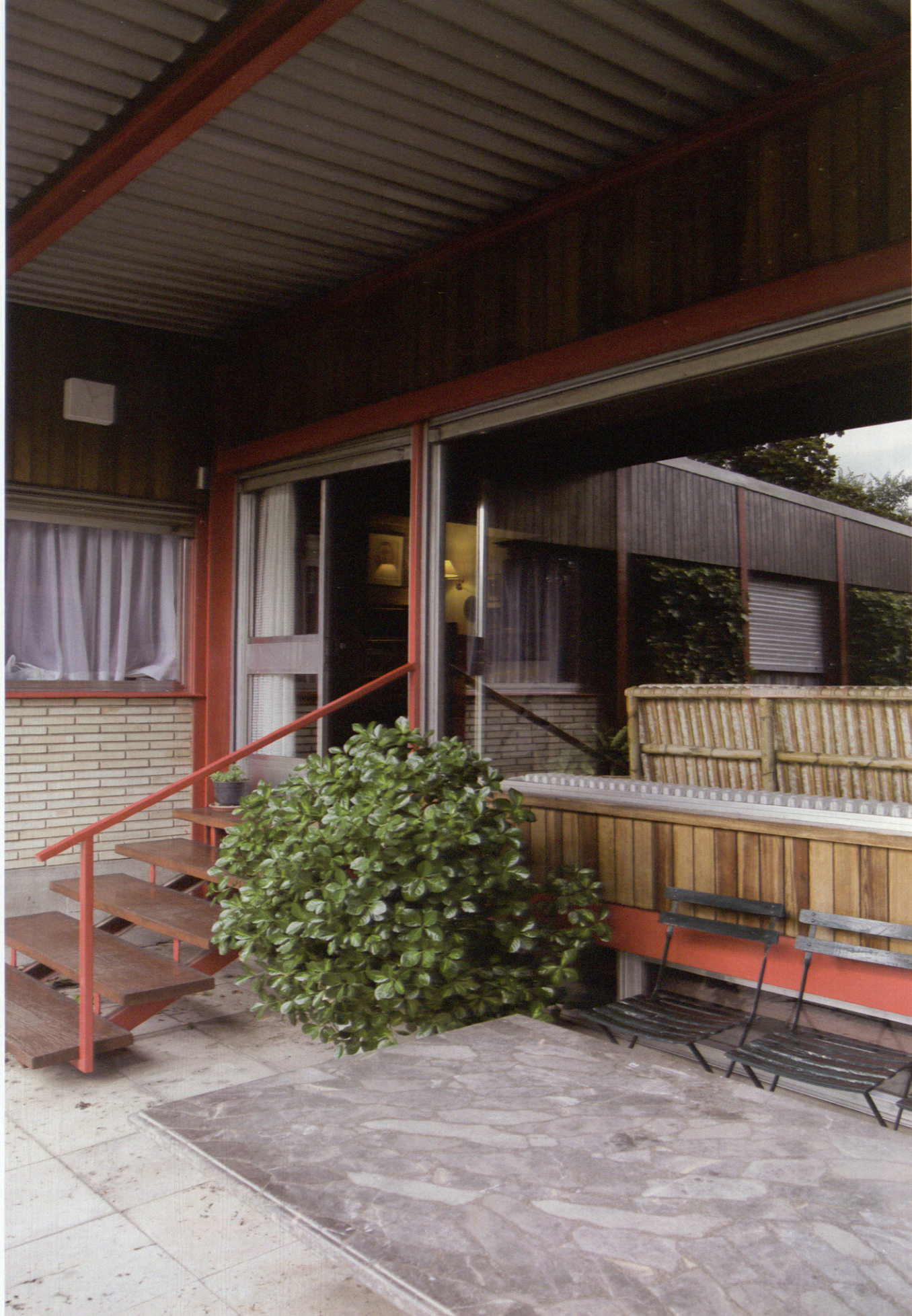
Casa Cabrero en Puerto de Hierro. Francisco de Asís Cabrero, 1961. Encuentro del ala norte-sur (habitaciones) con el este-oeste (estancia y estudio). Fotografía: Luis Asín. Cabrero House in Puerto de Hierro. Francisco de Asís Cabrero, 1961. North-south wing (bedrooms) meeting with east-west wing (living room and studio). Photography: Luis Asín.
